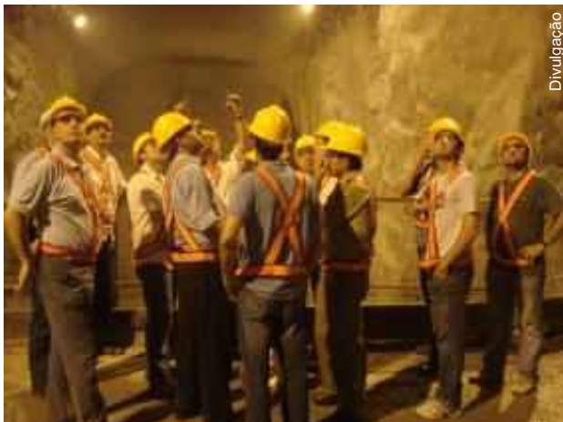
Caverna artificial com 40 metros de altura abrigará a casa de forças
