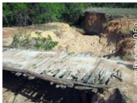
Leito seco do córrego Barroquinha, em Vazante.
