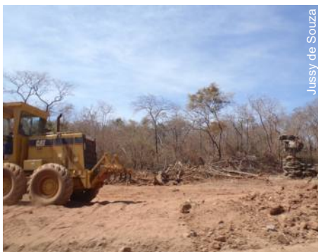
Maquinário pesado abrindo caminho
